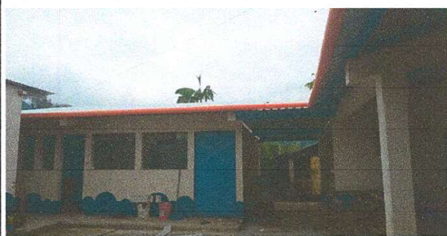
Foto 2: Nuevo techo de lamina en area de cocina y baños.
