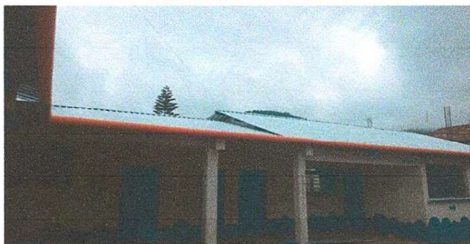
Foto 1: Vista actual de techo de laminas en áreas de dos aulas, direccion y bodegas.
